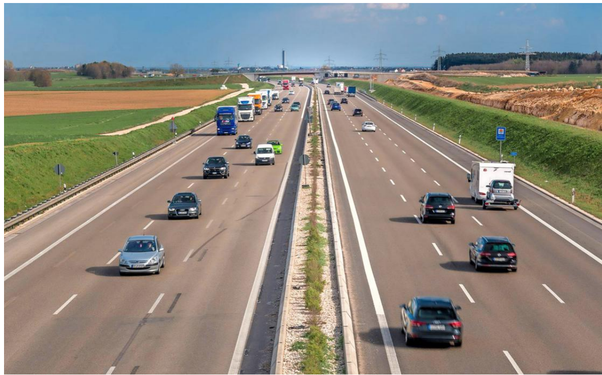
Die A 8, hier Blick Richtung Temmenhausen, wird auf rund 23 Kilometern auf sechs Fahrstreifen verbreitert. FOTOS: RP TÜBINGEN
