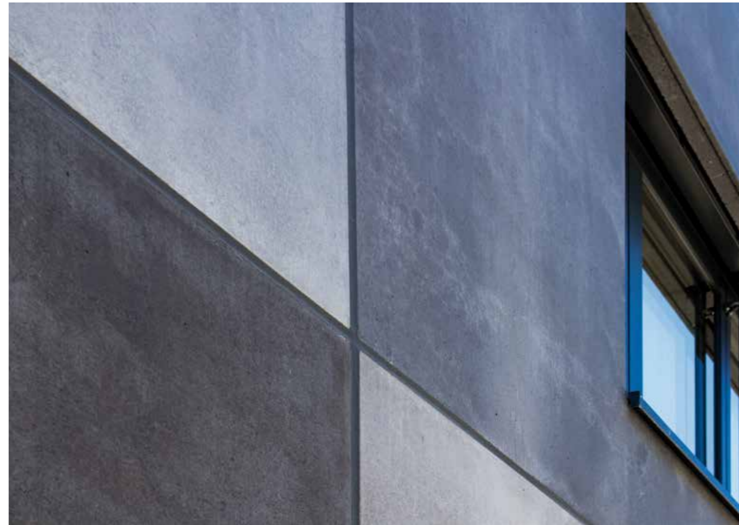
Abb. 5 (Bild oben) Die Fassade besteht aus 43 durchgefärbten Sandwichbetonelementen
