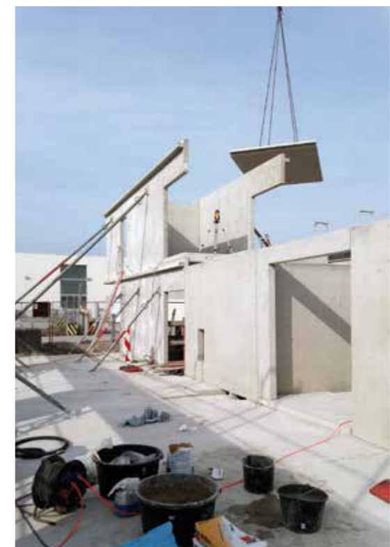
Abb. 5 (Bild oben) Die Fassade besteht aus 43 durchgefärbten Sandwichbetonelementen
