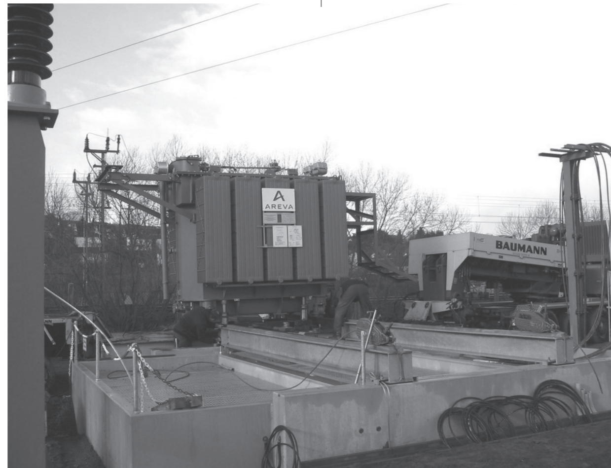
Direktes überladen von Tieflader auf Transformatorstand
