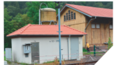
Das erweiterte Modulgebäude in Unterreichenbach
