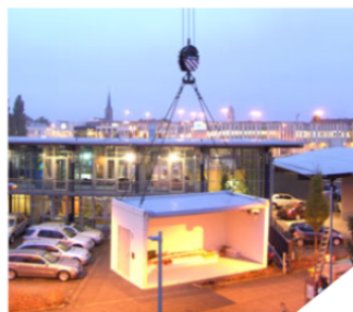
Stellen des Modulgebäudes per Autokran
