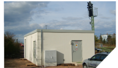
Modulgebäude in Landau
