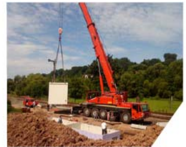
Stellen des Modulgebäudes in Eppelborn
