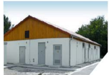
Modulgebäude in Buggingen
