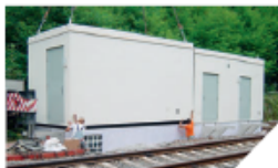
Stellen des Modulgebäudes in Pforzheim-Weißenstein
