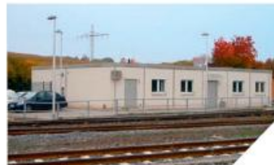
Modulgebäude in Groß Umstadt-Wiebelsbach
