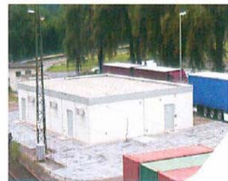
Modulgebäude in Oberlahnstein
